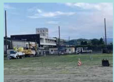
▲工事時の様子
