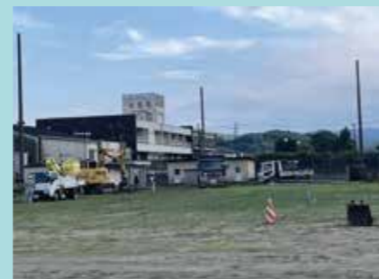
▲工事時の様子
