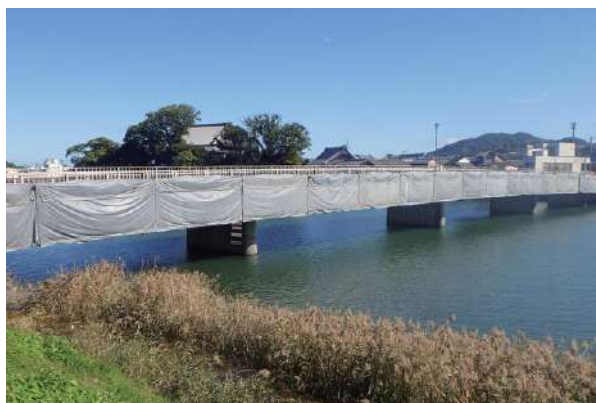
万里橋の補修の様子
