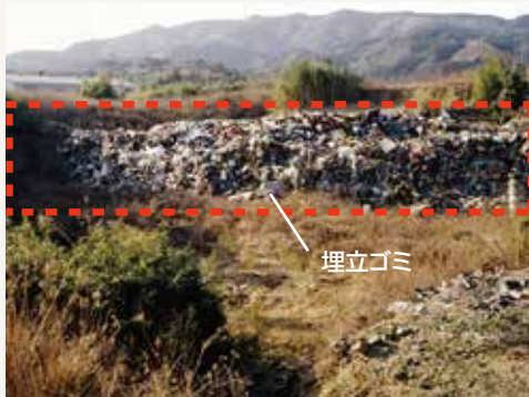
▲平成7年頃の旧不燃物埋立処分場
