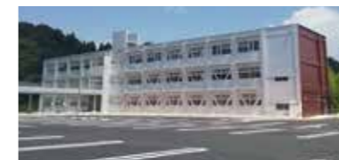
▲改修後の普通教室棟
