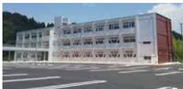
▲改修後の普通教室棟
