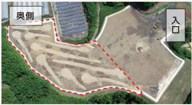
▲アンジュレーション(起伏)施工中(6月16日時点の様子)
