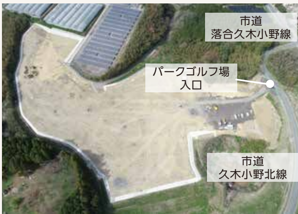
▲令和5年3月現在の状況(造成工事完了)
