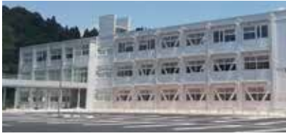
▲改修後の旧野津高校校舎
