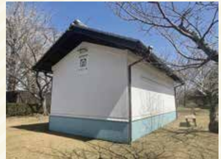
▲増設予定の臼杵公園防災倉庫
