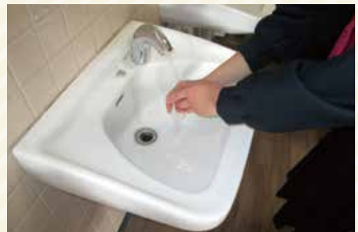
▲市内小中学校のトイレ手洗い自動水栓化
