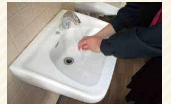
▲市内小中学校のトイレ手洗い自動水栓化
