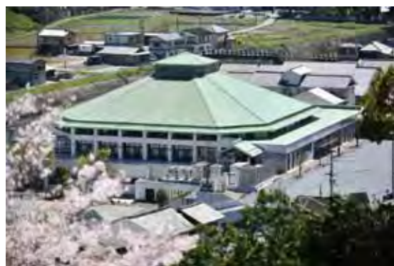
▲復旧した乙亥会館
