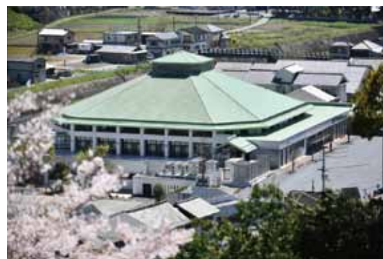
▲復旧した乙亥会館
