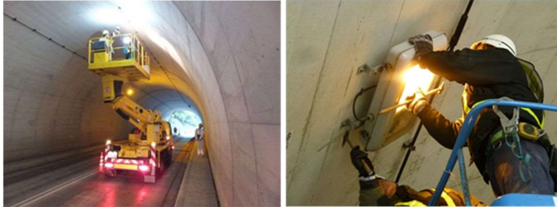
定期点検の様子
