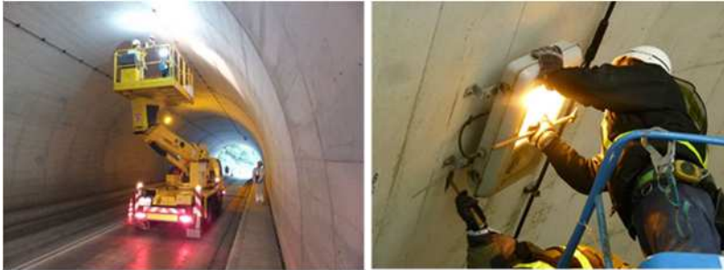
定期点検の様子
