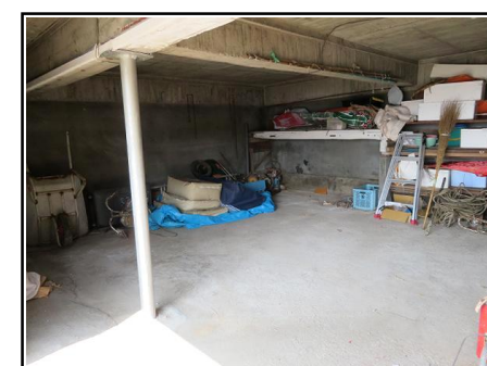
シャッター付き倉庫(1階)
