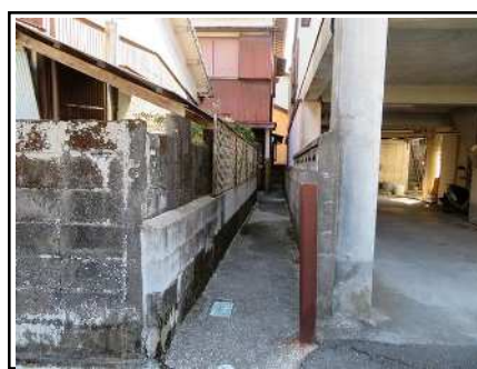
敷地入口(間口約1m)
