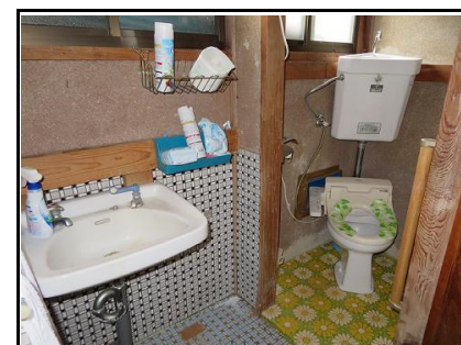
トイレ&洗面台
