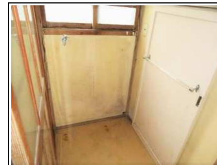
洗濯機置き場
