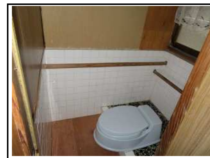
トイレ(汲み取り)
