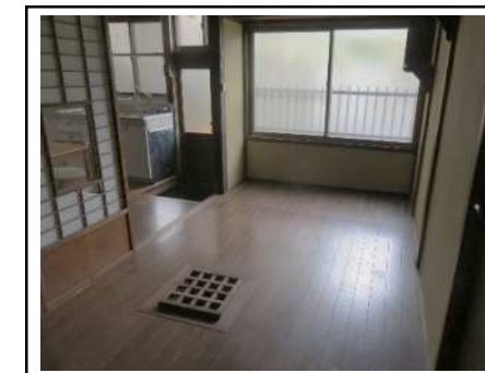
板間・囲炉裏(1階)
