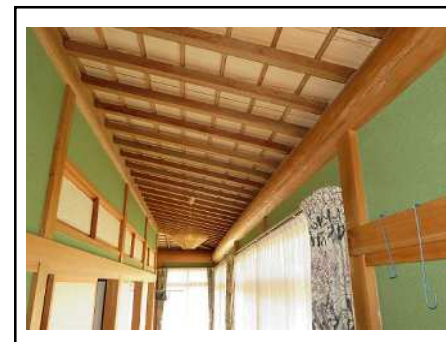
和室縁側の梁
