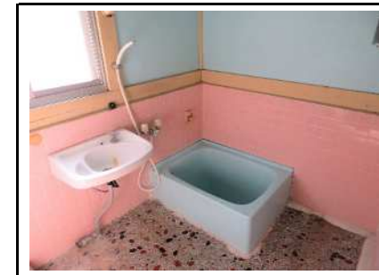
浴室・洗面台
