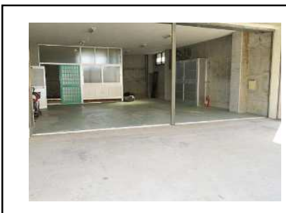
倉庫(車庫エリア)
