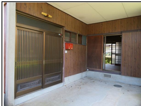
玄関前スペース
