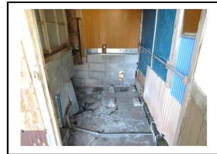
浴室スペース
