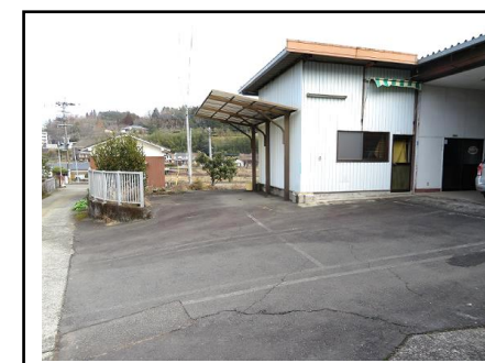
事務所・倉庫部分 駐車スペース
