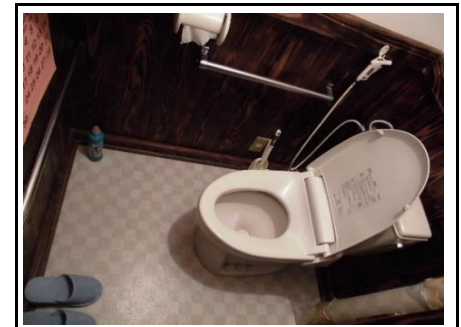
トイレ(簡易水洗)
