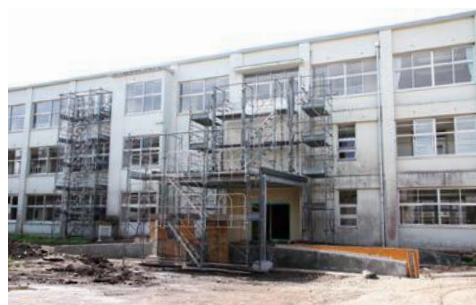
改修が進む旧臼杵商業高校の校舎
