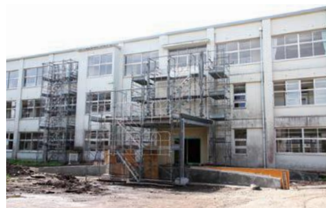
改修が進む旧臼杵商業高校の校舎
