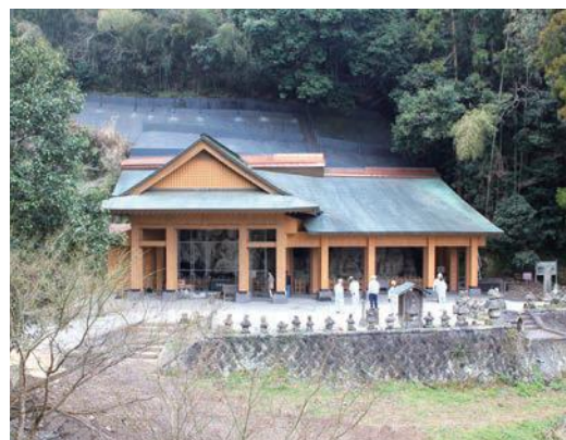
ホキ石仏第2群覆屋改修
