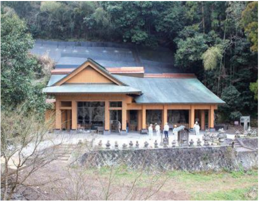
ホキ石仏第2群覆屋改修
