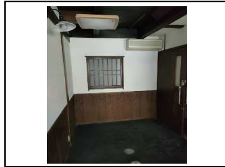
トイレ前スペース
