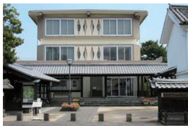
平成27年 大規模改修後の白杵図書館
