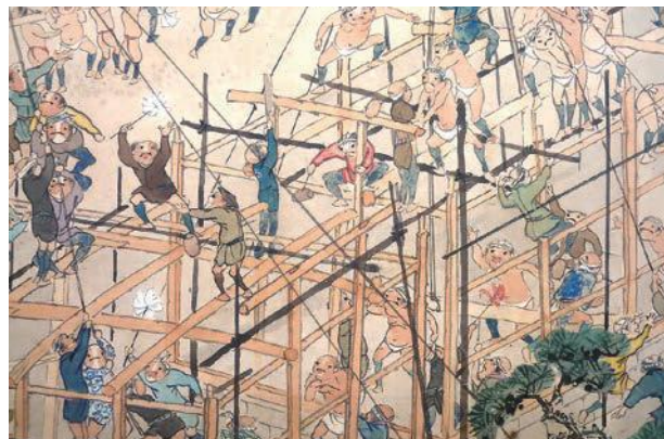
梁や柱を組み上げる様子
