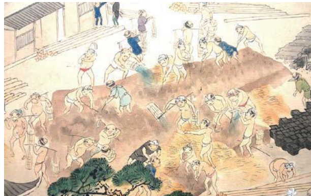
屋根瓦の下に敷くための葺き土を練る様子
