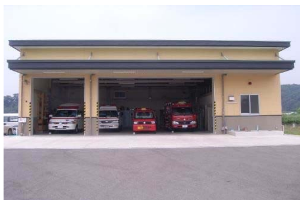
野津分署 位置：臼杵市野津町大字宮原4267番1 敷地面積：6,060.23㎡ 建築面積：589.7㎡ 平成19年2月20日竣工
