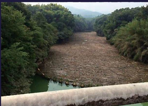
乙見ダムに堆積した流木
