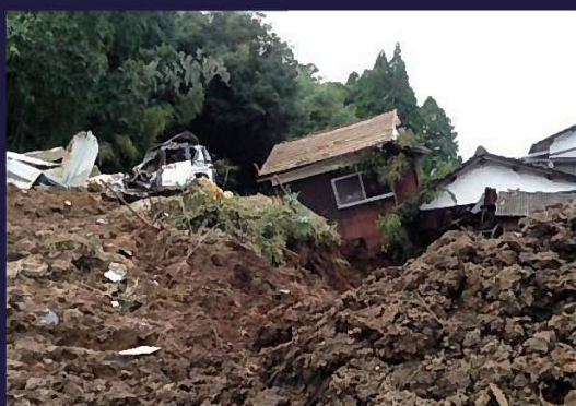
崩れた土砂(北海添)
