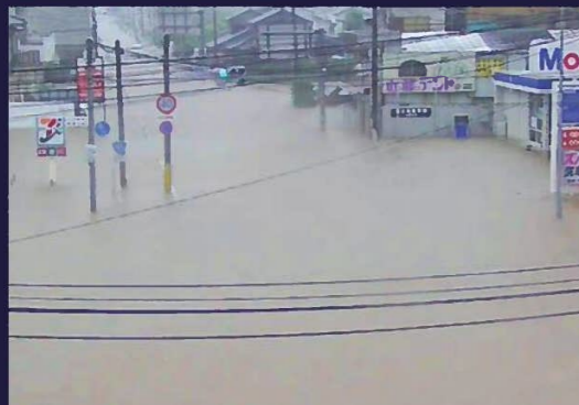
冠水した土橋交差点
