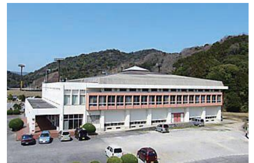
諏訪山体育館
