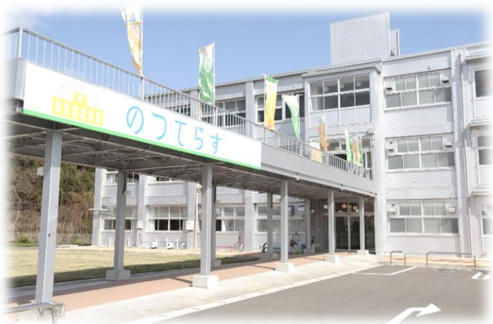
臼杵市多世代交流館(のつてらす) 令和7年オープン
