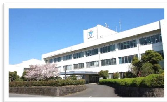
建設から50年を経過した白杵市役所白杵庁舎
