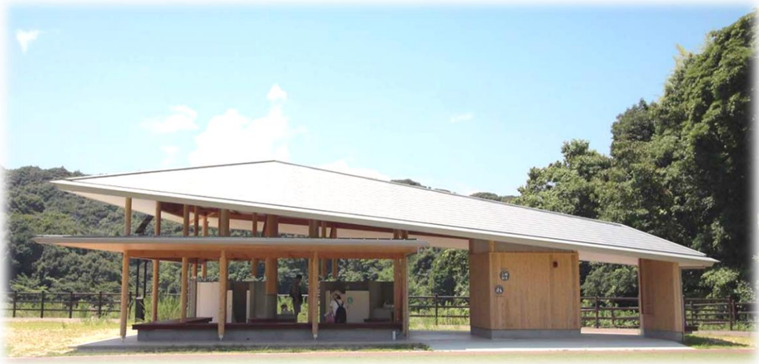
白杵市総合運動公園子ども広場こどもトイレ(令和4年建築)
