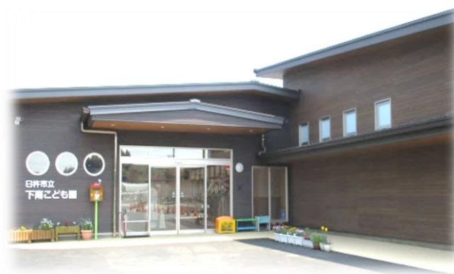
白杵市立下南こども園(令和2年建築)
