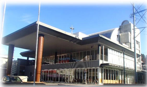
白杵市役所野津庁舎
