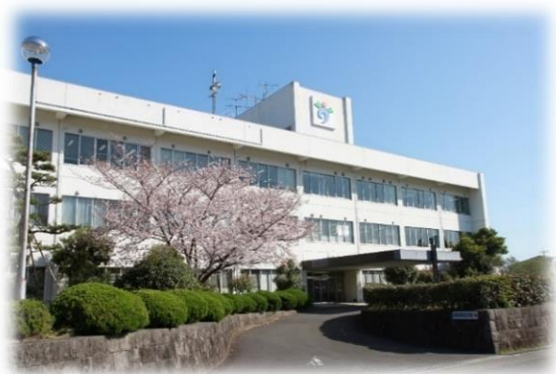
白杵市役所白杵庁舎
