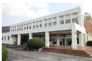
諏訪山体育館
