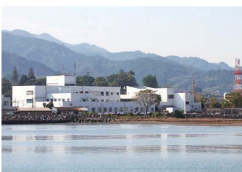
海側から見た白杵庁舎
