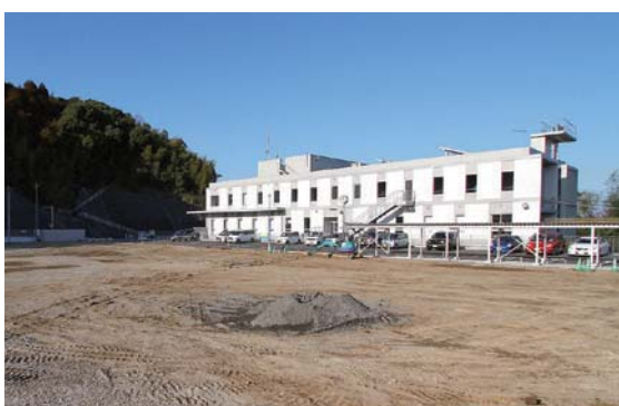
(仮称)西南地区交流センターの建設予定地
