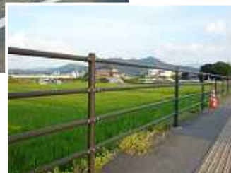
ダークブラウン塗装の鋼製防護柵
