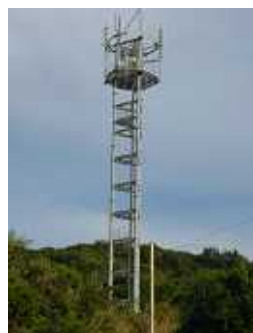
溶融亜鉛メッキ低光沢仕上げの携帯電話電波塔
