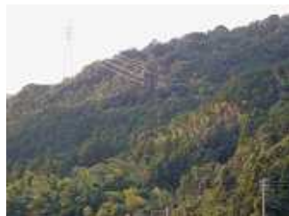
ダークブラウン塗装の送電線鉄塔
