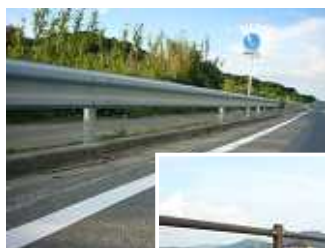
溶融亜鉛メッキ低光沢仕上げのガードレール
