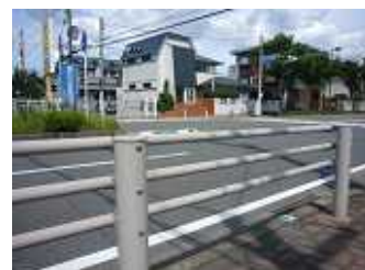
グレーベージュ塗装の鋼製防護柵
