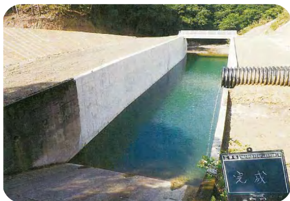
石場ダムの減勢池 改修完了
