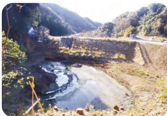
乙見ため池改修の様子
