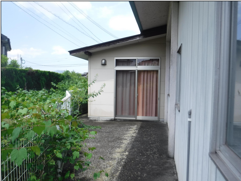
建物外観（裏面）
