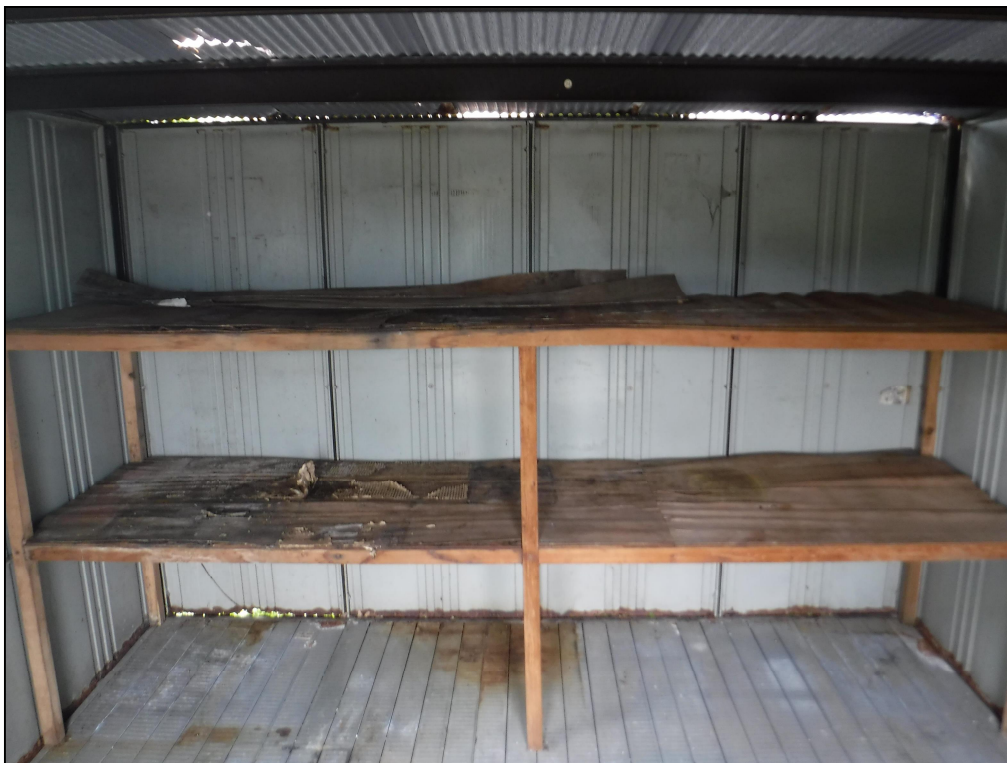
建物外観（倉庫内部）
