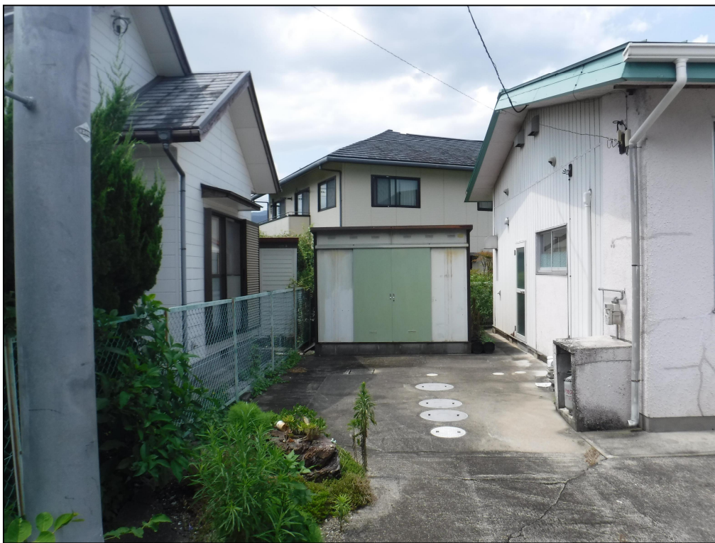
建物外観（倉庫）
