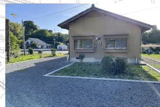
3-2-1 白杵市おためしハウス「ほっとさんの家」 施設区分：お試し居住施設
